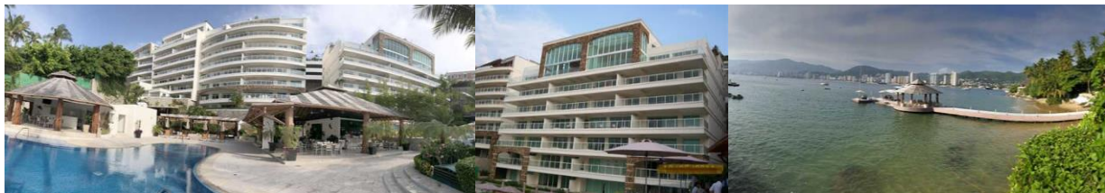
Supervisión y coordinación de obra en el desarrollo BVG Villa Alejandra Acapulco, Guerrero.
