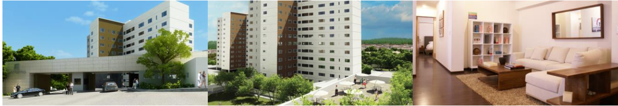
Supervisión de acabados en el desarrollo Entorno, Cuajimalpa, Ciudad de México.
