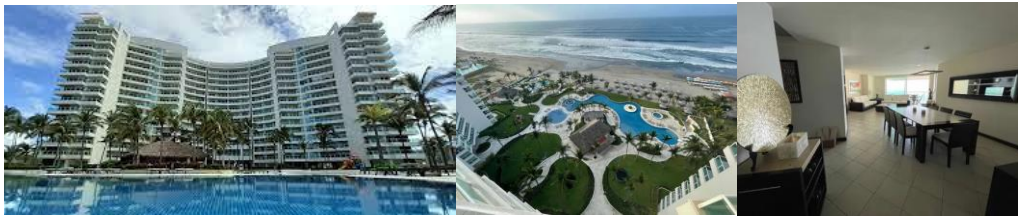
Supervisión y coordinación de obra en el desarrollo Las Olas Acapulco, Guerrero.
