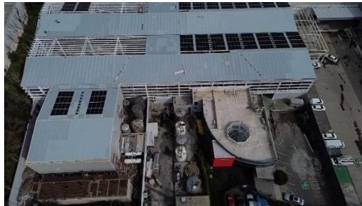
Proyecto ejecutivo y construcción de planta de pinturas General Paint en Lerma de Villada, Estado de México.
